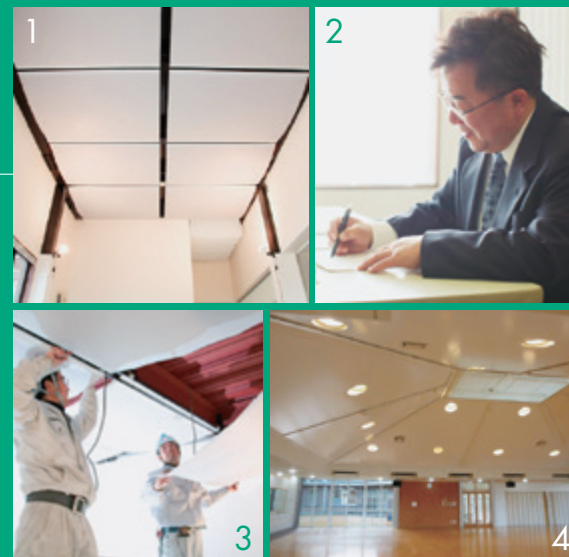
1 膜天井の施工例1。明るいイメージに変化。 2 代表取締役 牛垣 和弘氏。 3 膜天井の施工中。膜材は軽いので施工が容易。 4 膜天井の施工例2。開放的な空間に変化。
