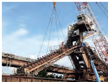
▲解体対応する業界例（製鉄製造設備）
