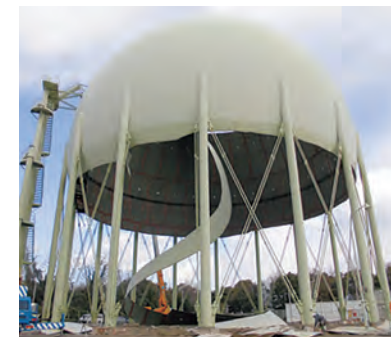
▲石油タンクの解体に関する特許工法「リンゴ皮むき工法※商標登録済み」
