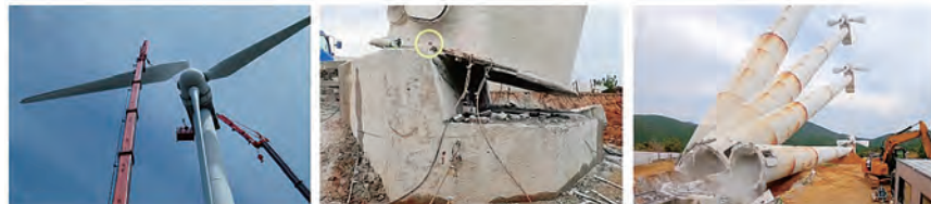
▲風力発電の解体に関する特許工法
