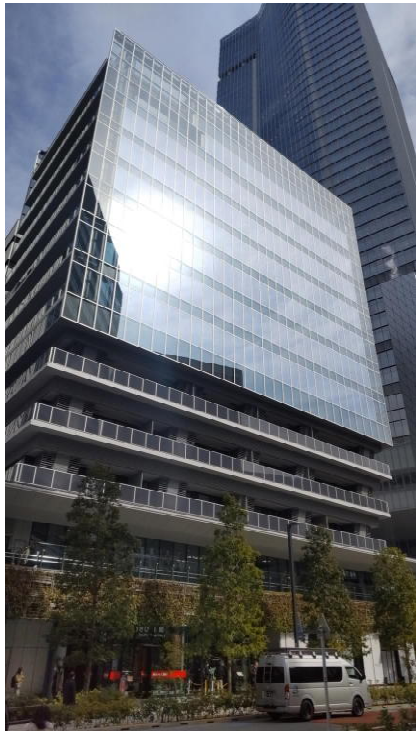
江戸見坂テラス外観 (12階建てビル)
