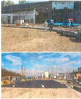
愛知県の大手メーカーに採用され、「ごみ焼却施設の敷地内道路」に施工されたGDS工法
