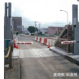
<高速道路 料金所ゲート用>
