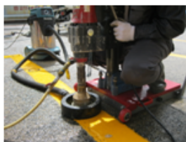
ケースルビットによる 施工現場
