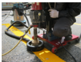
ケーズルビットによる 施工現場
