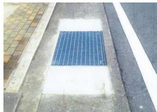
また、グレーチング受枠は、両端面から突出する固定用アンカーを備えており、現場打設するコンクリートと一体化して固定されるため、従来のように側溝の周囲をはつって撤去する工事が不要になります。既存の道路や側溝のコンクリートを壊すことなく施工できるため、道路の通行止めも必要なく安全に通行することが可能で、従来工事の 10 分の 1 の工程で施工ができ、工事費の削減にも寄与しています。
