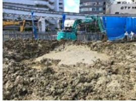
泥状の掘削土砂
