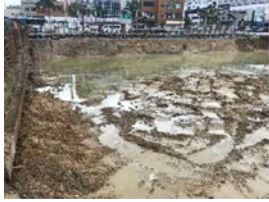
基礎工事直後に降雨
