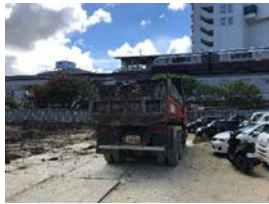
改良土の場外搬出
