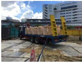
泥土改質材搬入作業
