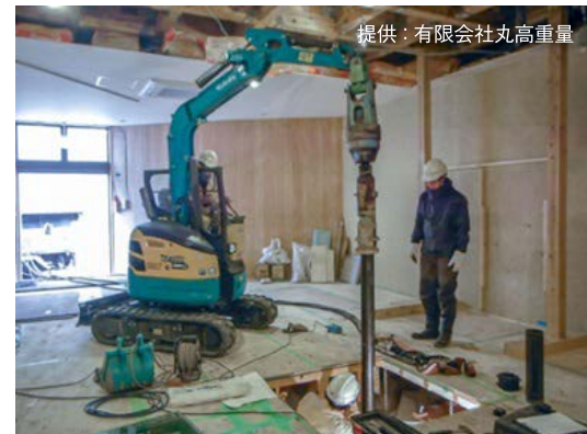
超狭小地での鋼管杭（マルコウフィンパイル）
