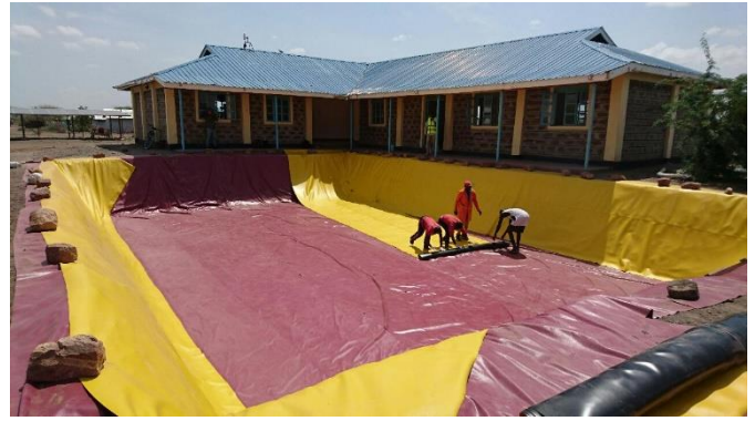
ケニア・カロベイエイ新居住区 における「ためとつと」の工事風景
